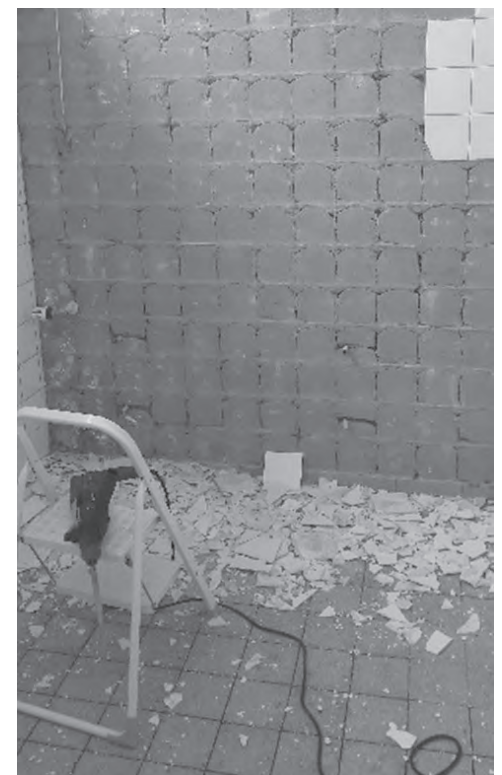
Unser Hausmeister war ebenfalls sehr fleißig und hat in den Toiletten die Fliesen entfernt.
