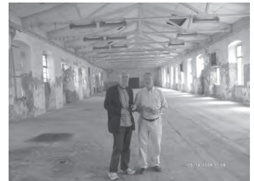
Der Innenraum des Arbeitslagers, kurz vor dem Abriss
