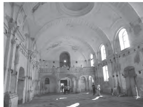
Zustand im Innenraum der ehem. Bulkeser Kirche im August 2019
